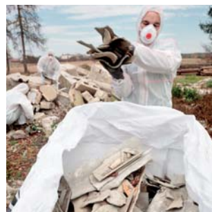
Demontaż i bezpieczne składowanie wyrobów zawierających azbest z obszaru województwa małopolskiego
